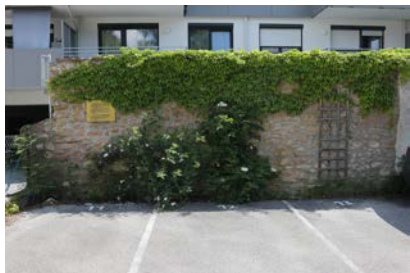
Neunkirchen, Mauerrest der mittelalterlichen Synagoge
